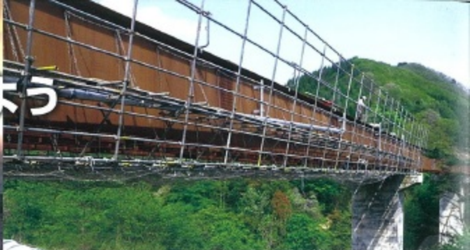
湯沢栗駒公園線(黒竜橋) 橋梁架替工事
