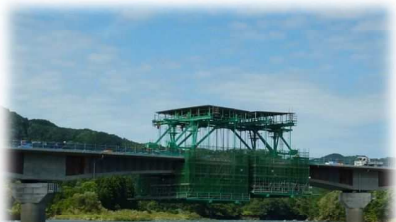
国道103号(大館)葛原バイパスの橋の工事 鹿角と大館を結ぶ道路の工事を行っています。
