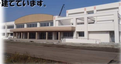
大館地区統合高校(仮称)の建築工事 旧大館商業高等学校跡地に3校を統合した 統合校を建てています。
